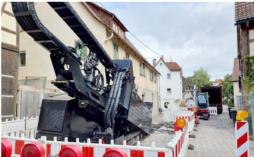
Abb. 01: Elektrisches Spülbohrgerät: im Rahmen des Projekts erstmals auf einer realen Baustelle eingesetzt [Foto: Netze BW]
