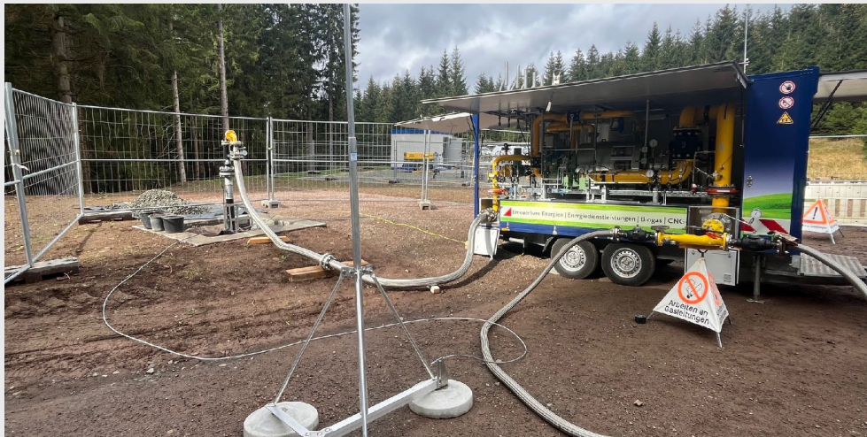
Abb. 03: Mobile Gasdruckregelanlage im Einsatz [Foto: Ohra Energie GmbH]
