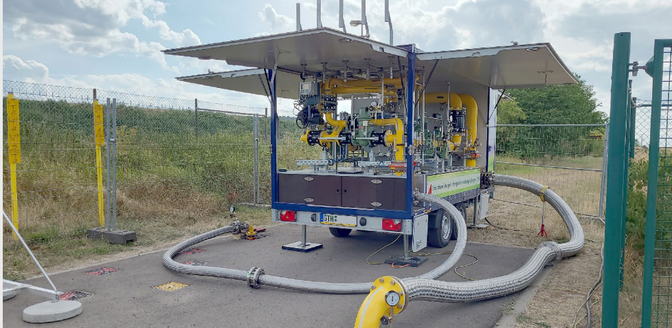
Abb. 02: Mobile Gasdruckregelanlage im Einsatz [Foto: Ohra Energie GmbH]
