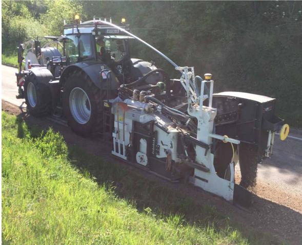
Abbildung 10: Zugmaschine mit Vorrichtung für das Bankettfräsverfahren.
