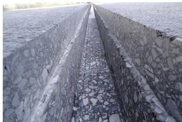
Abbildung 15: Diamantschleifscheiben und abgestuftes Rechteckprofil in einer Asphaltoberfläche.
