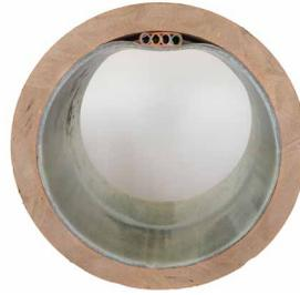
Abbildung 38: Einbau Schlauchliner zur Kanalsanierung und Schutzrohrpaket für Kabel.
