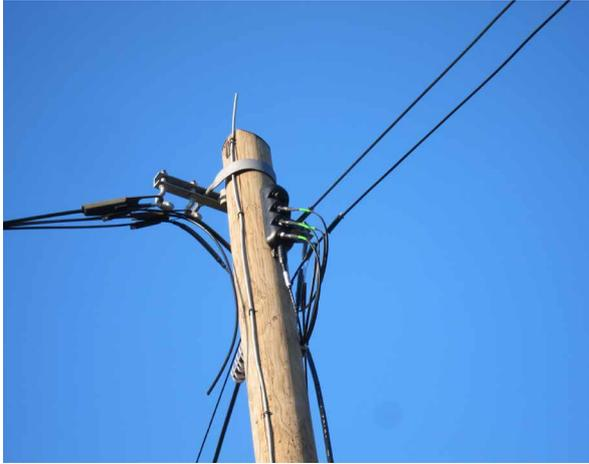
Abbildung 41: Glasfaser-MastBox für Hausanschlüsse.
