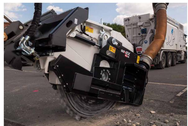
Abbildung 7: Eindringen einer Fräse in den Asphalt.
