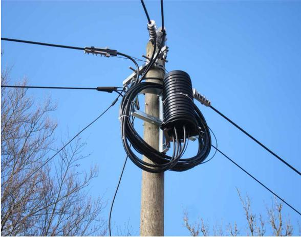
Abbildung 39: Glasfasermuffe am Mast.
