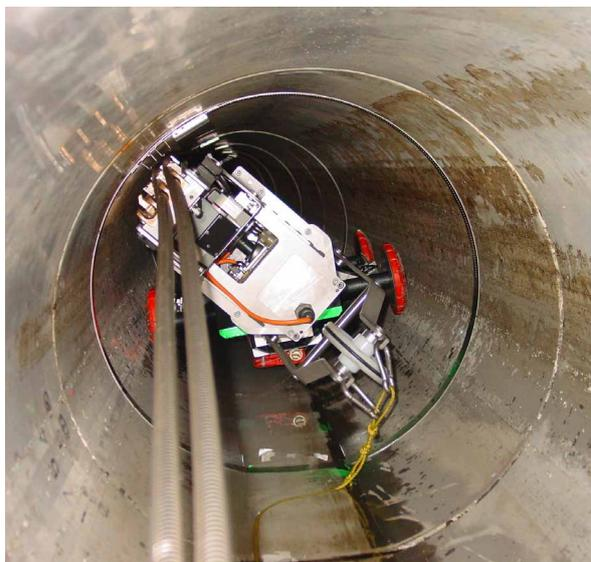
Abbildung 36: Roboter im Abwasserkanal beim Einbringen zweier Leerrohre in die Clips einer Innenbride.
