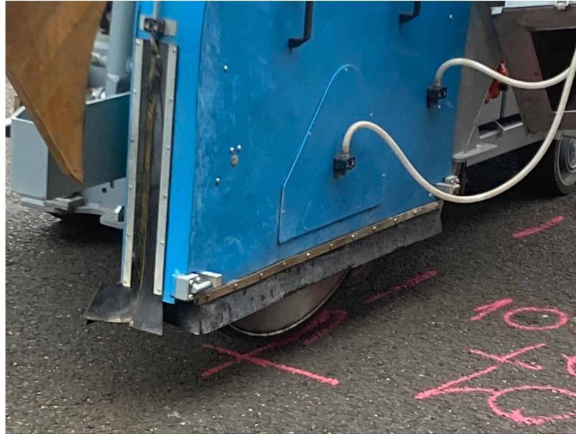
Abbildung 14: Diamantschleifscheiben und Schleifen im Asphalt mit Rechteckprofil.
