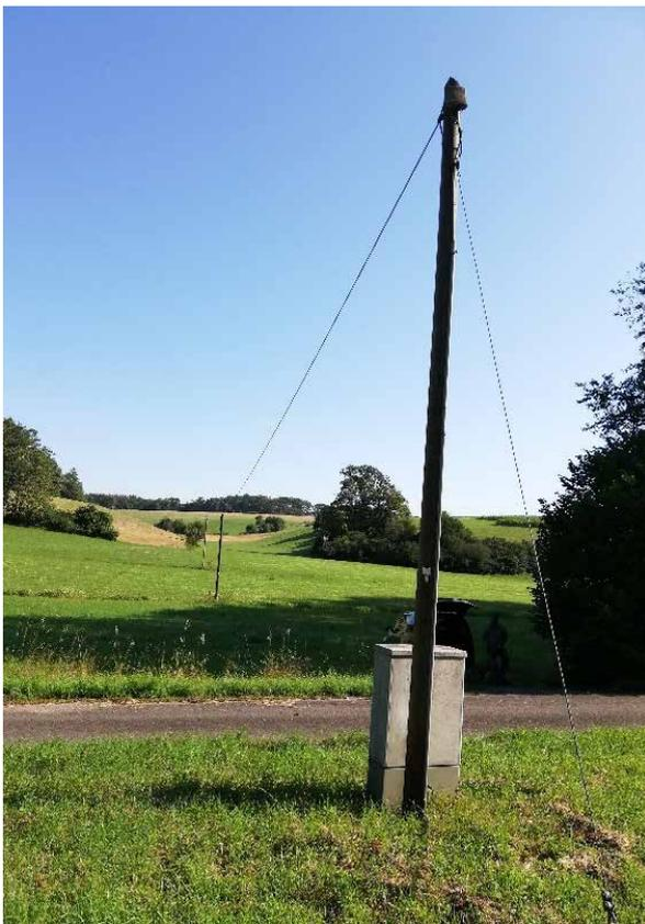
Abbildung 40: Oberirdische Telekommunikationslinie.
