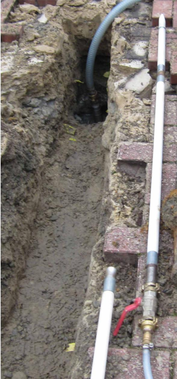
Abbildung 29: Spüllanze und Saugpumpe für das Spüllanzverfahren.
