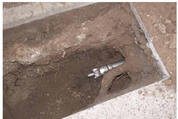
Abbildung 32: Ein Bodenverdrängungshammer erreicht eine Zielgrube.
