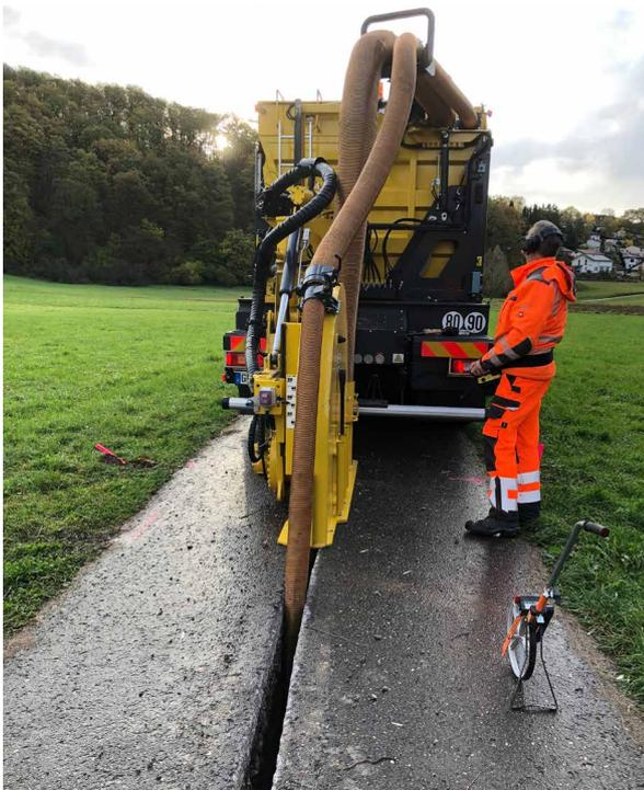
Abbildung 8: Fräsen im Asphalt mit einer Absaugvorrichtung.
