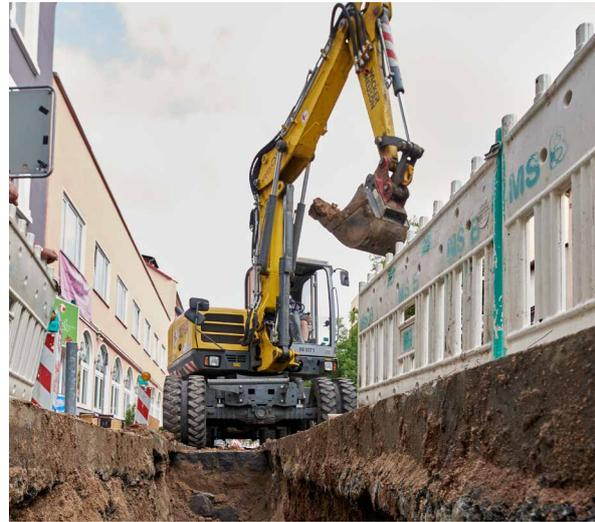
Abbildung 21: Bagger beim Ausschachten eines Grabens.
