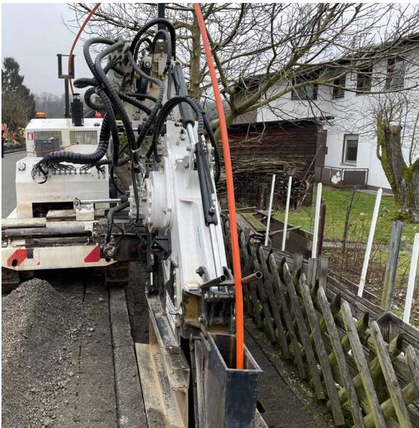
Abbildung 5: Fräsen im Gehweg mit einer Kettenfräse und Legevorrichtung.
