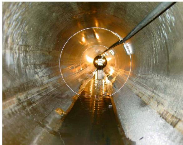
Abbildung 37: Verwendung von Spannringen (sog. Briden).
