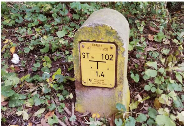
Abbildung 1: Merkstein zum Auffinden des Zugangs zu einer Gasleitung
