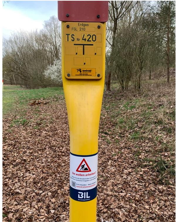
Abbildung 3: Schilderpfahl als Hinweis für eine Gasfernleitung im Gelände
