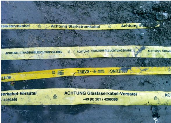
Abbildung 8: Darstellung unterirdisch verlegbarer Trassenwarnbänder
