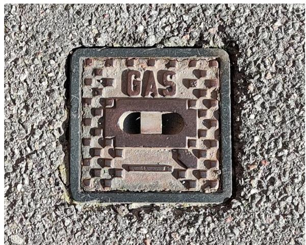
Abbildung 4: Schieberkappe für eine Gasleitung
