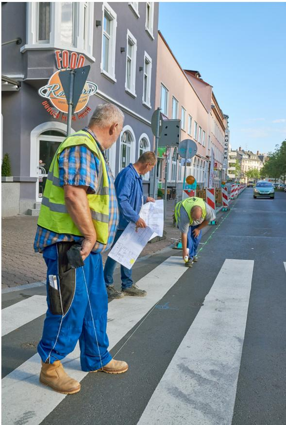
Abbildung 10: Markierung unterirdisch verlegter Bestandsleitungen
