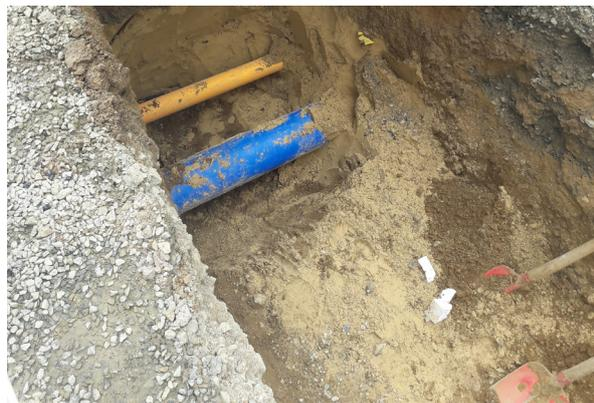
Abbildung 11: Suchgraben mittels Handschachtung
