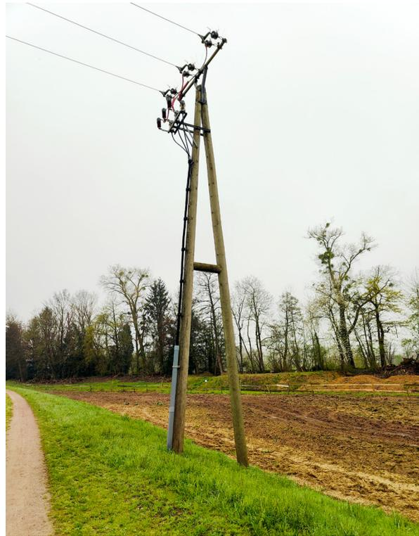
Abbildung 7: Strommast mit unterirdischer Zuleitung
