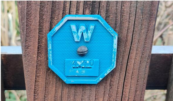
Abbildung 5: Hinweisschild für die Lage eines Hausanschlusses einer Wasserleitung
