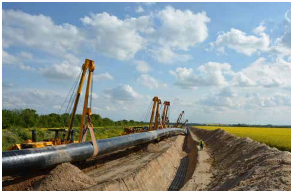
Absenken der EUGAL-Rohre bei Großenhain (Brandenburg)
