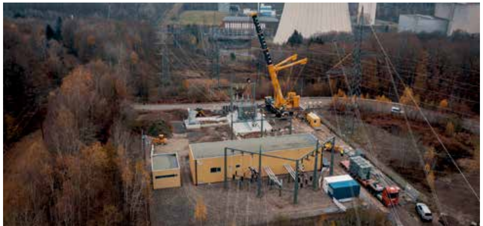
Mit schwerem Gerät wird der Trafo aufgestellt
