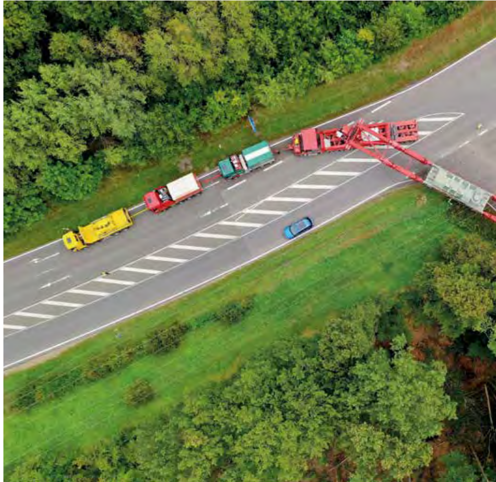
Präzise um jede Kurve – aufwendiger Abtransport des alten Trafos mit einem insgesamt 70 Meter langen Zug.
