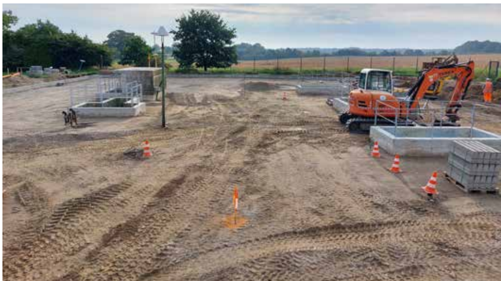
Vorbereitung für Pflasterarbeiten nach Abtrag Betonstraße und Austausch der Gasleitung
