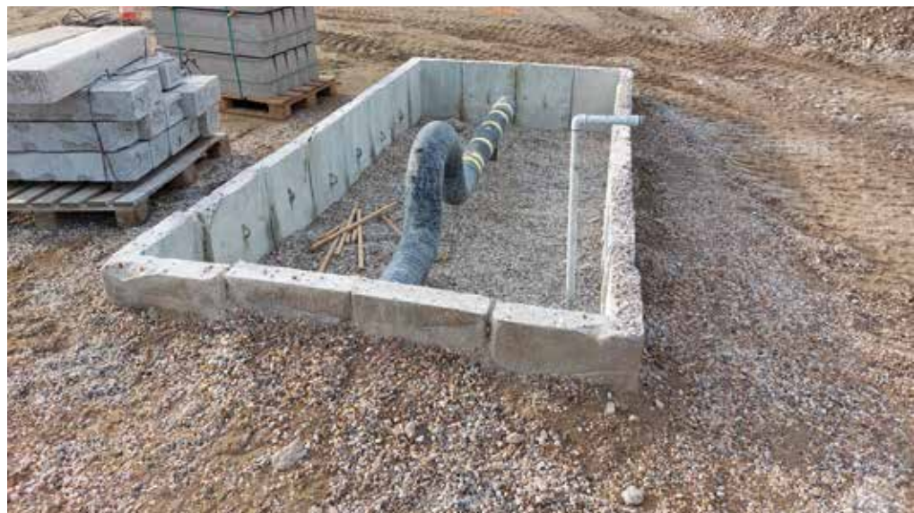
Erneuerung der Umhüllung im Zuge des Neuausbaus der Kiesgrube (Simulation Oberflächenbrand)
