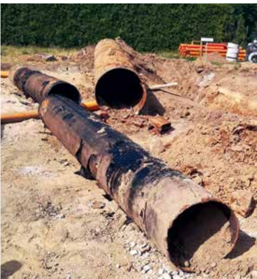
Ausgebaute Rohre St DN 600 und 800 welche als Mantelrohre der MD- und HD-Leitungen genutzt wurden
