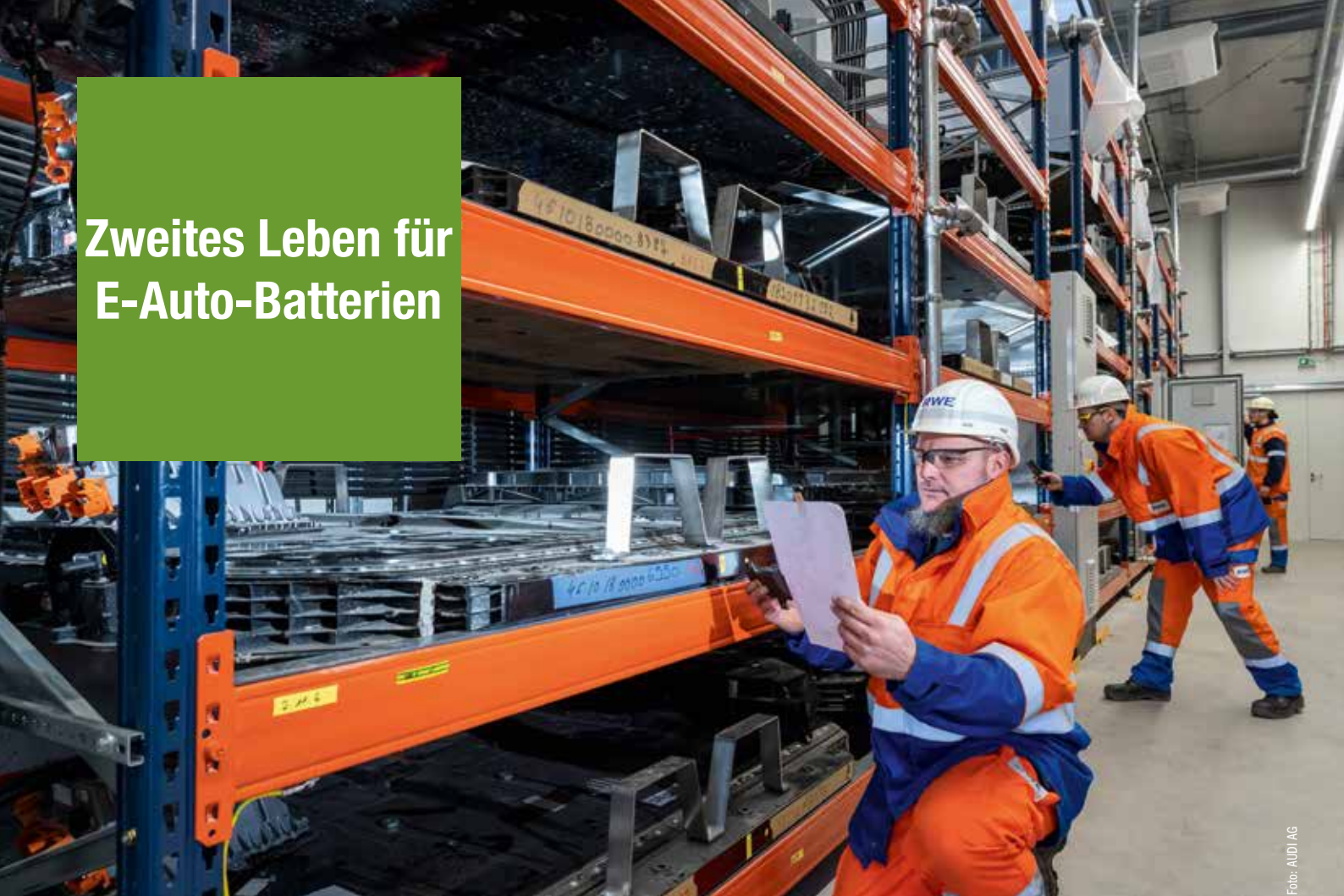
Speicherhalle im Pumpspeicherwerk Hengsteysee
