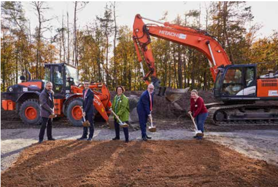
Abgebildet sind v.l.n.r.: Nils Höger, Technischer Projektleiter, Sebastian Schremp, Oberbürgermeister der Stadt Rheinstetten, Katrin Flinspach, Geschäftsführerin der terranets bw GmbH, Dirk Güsewell, Vorsitzender des Aufsichtsrates der terranets bw GmbH und Mitglied des Vorstands der EnBW Energie Baden-Württemberg AG, Susanne Kurschat, Kaufmännische Projektleiterin
