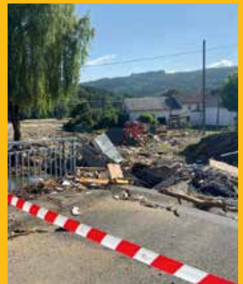
Verwüsteter Brückenübergang (Quelle: Syna GmbH)
