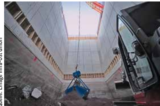
Abbildung 2: Senkkasten bei Beginn Absenkvorgang
