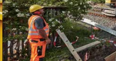
Bild 2: Ammertalbahn, Einbau Duktilrammpfahl,
