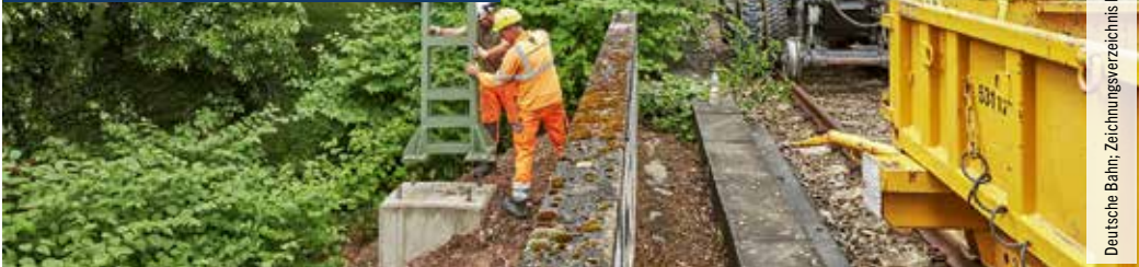
Bild 1: Ammertalbahn, Stellen eines Flachmastes, LEONHARD WEISS GmbH & Co. KG
