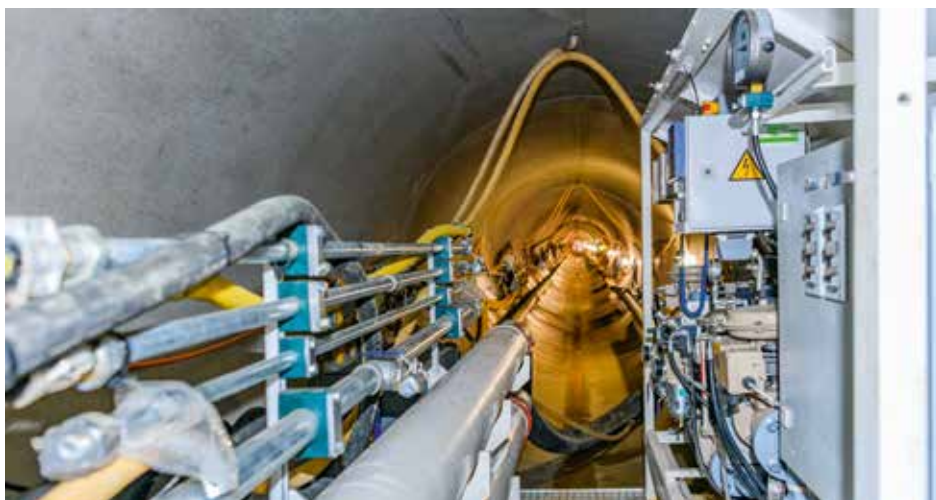
Abbildung 4: Tunnelbohrmaschine im Einsatz
