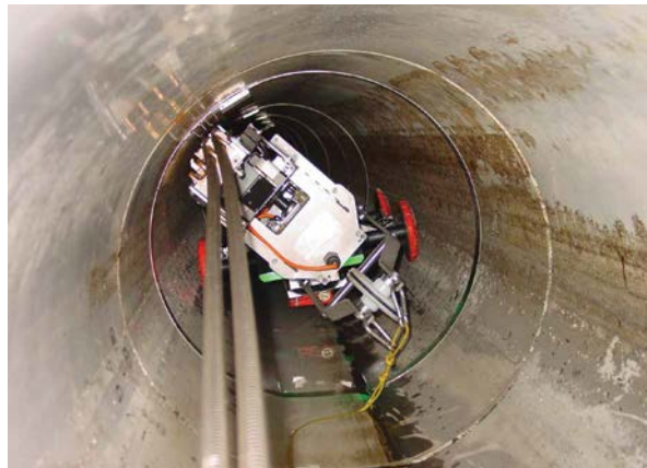
Abbildung 44: Verlegeroboter im Abwasserkanal beim Einbringen zweier Leerrohre in die Clips einer Innenbride. Quelle: Fast Opticom AG
