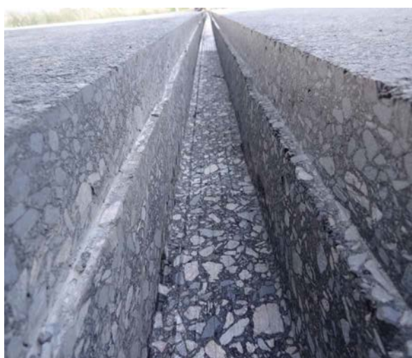
Abbildung 20: Stufenschlitz in einer Asphaltoberfläche Quelle: Österreichische Glasfaser Verlegungsges. m.b.H
