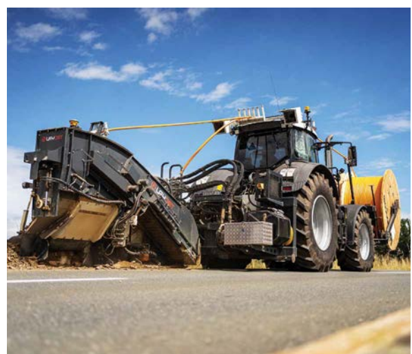
Abbildung 16: Zugmaschine mit Vorrichtung für das Bankettfräsverfahren Quelle: LAYJET Micro – Rohr Verlegegesellschaft m.b.H.
