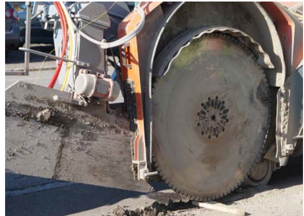
Abbildung 18: Diamantschleifscheibe und Pflug zum Einlegen von Leerrohren
