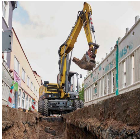
Abbildung 6: Bagger beim Ausschachten eines Grabens Quelle: Verband Sichere Transport- und Verteilnetze/KRITIS e.V. (VST)/Tom Wolf
