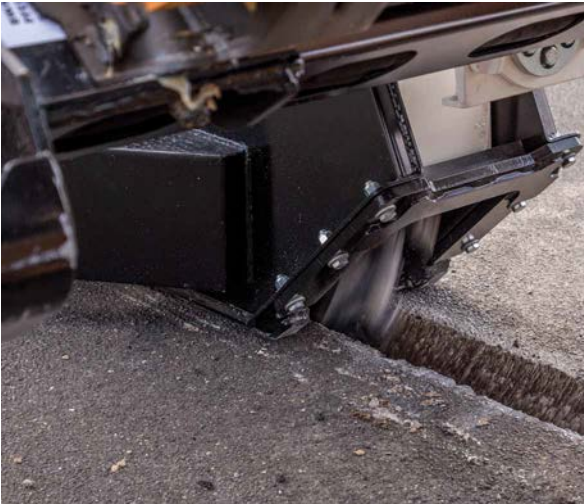
Abbildung 13: Fräsen in Asphalt Quelle: Simex s.r.l.
