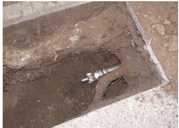
Abbildung 40: Eine Erdrakete erreicht eine Zielgrube Quelle: TRACTO-TECHNIK GmbH & Co. KG
