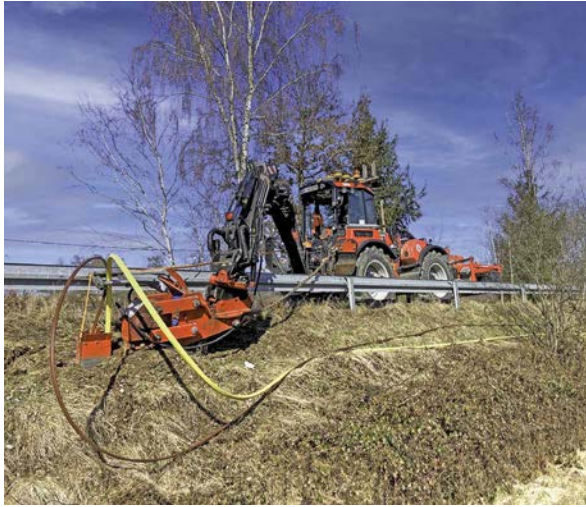
Abbildung 25: Einsatz des Pflugverfahrens in unwegsamem Gelände Quelle: econtech GmbH
