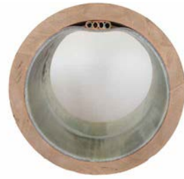
Abbildung 46: Einbau Schlauchliner zur Kanalsanierung und Schutzrohrpaket für Kabel Quelle: BKP Berolina Polyester GmbH & Co. KG
