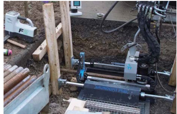
Abbildung 31: Mini-Spülbohrsystem, eingesetzt in einer Startgrube im Gehweg; Gestängemagazin Quelle: TRACTO-TECHNIK GmbH & Co. KG
