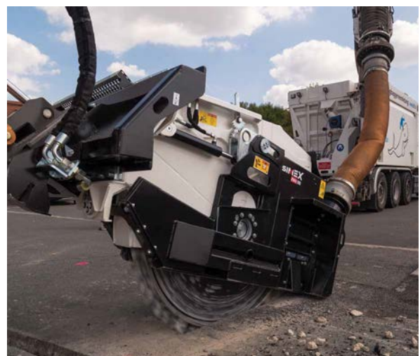
Abbildung 12: Eindringen einer Fräse in den Asphalt Quelle: Simex s.r.l.
